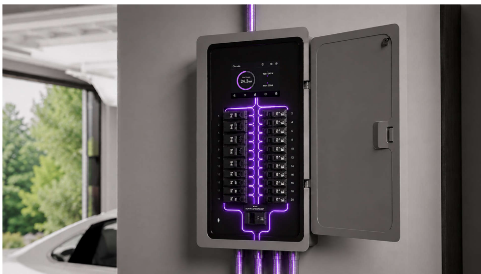
图 1. 智能面板解决方案提供远程负载管理、自动化和电路级控制
